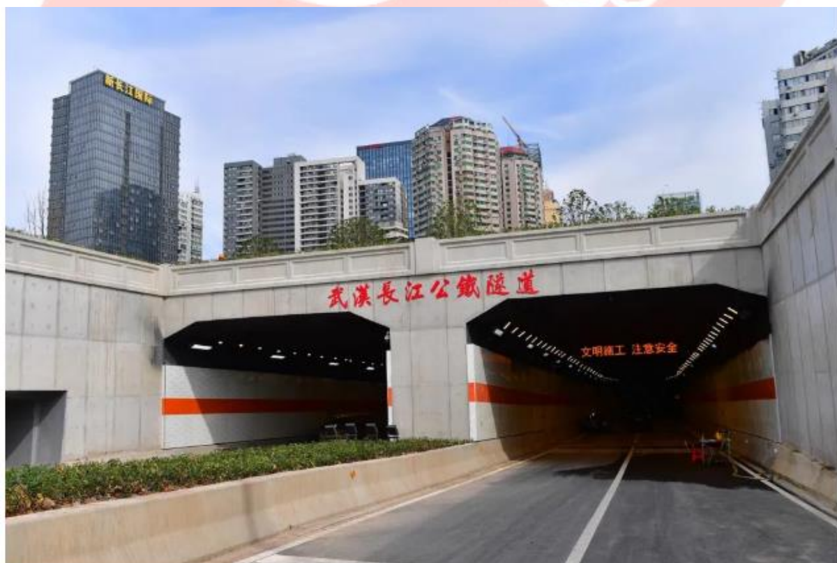
武汉长江公铁隧道洞口实景图
