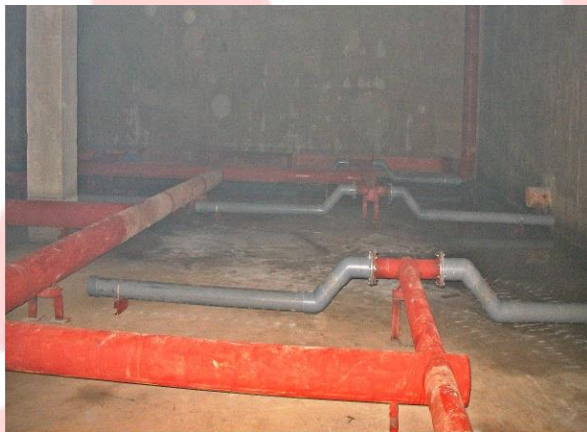
图3 蓄水槽安装实景
